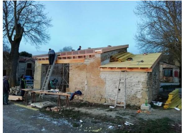
La soue est nettoyée, pose de la 1<sup>ère</sup> poutre et mise en place de la toiture
